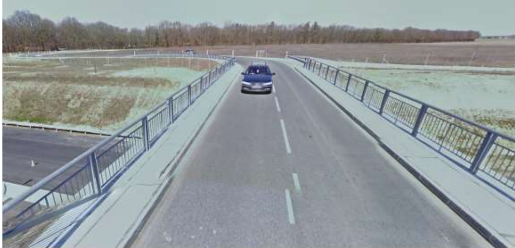
Franchissement de l'A19 le long de la route forestière
