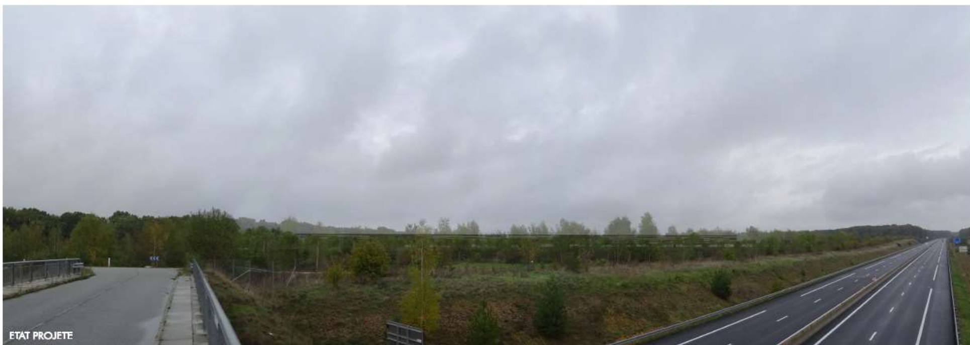
3 - INSERTION DEPUIS LE PONT, VERS LE NORD
